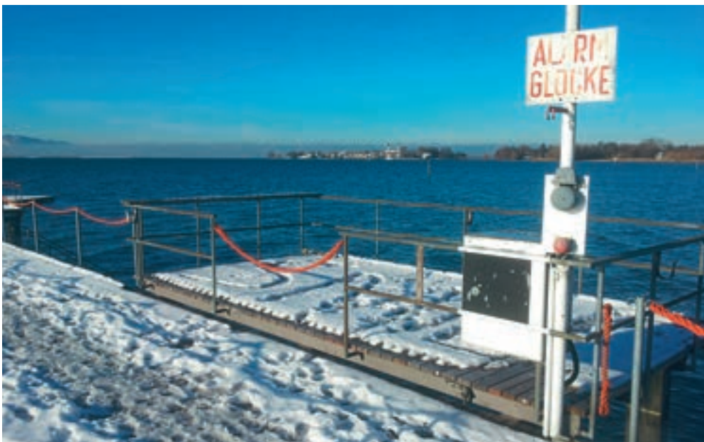
Um den Steg im Eichwaldbad muss nicht gerungen werden bei der Neukonzeption der Lindauer Bäder. Allerdings läuten längst die Alarmglocken wegen des andauernden hohen Defizits der Bäder. BZ-Foto: STS
