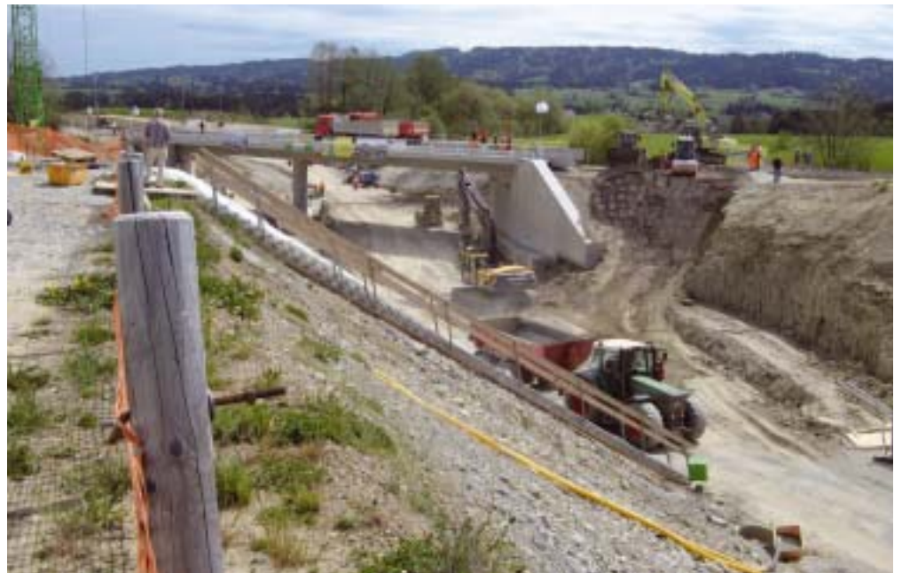
Derzeit entsteht zwischen Hergensweiler und Hergatz eine Bahnunterführung für die B12 um den gefährlichen Bahnübergang in Stockenweiler zu ersetzen. Diese Baustelle zeigt in etwa die Größenordnung der von den Stadt Lindau angedachten Bahnunterführung am Langenweg. BZ-Foto: Privat
