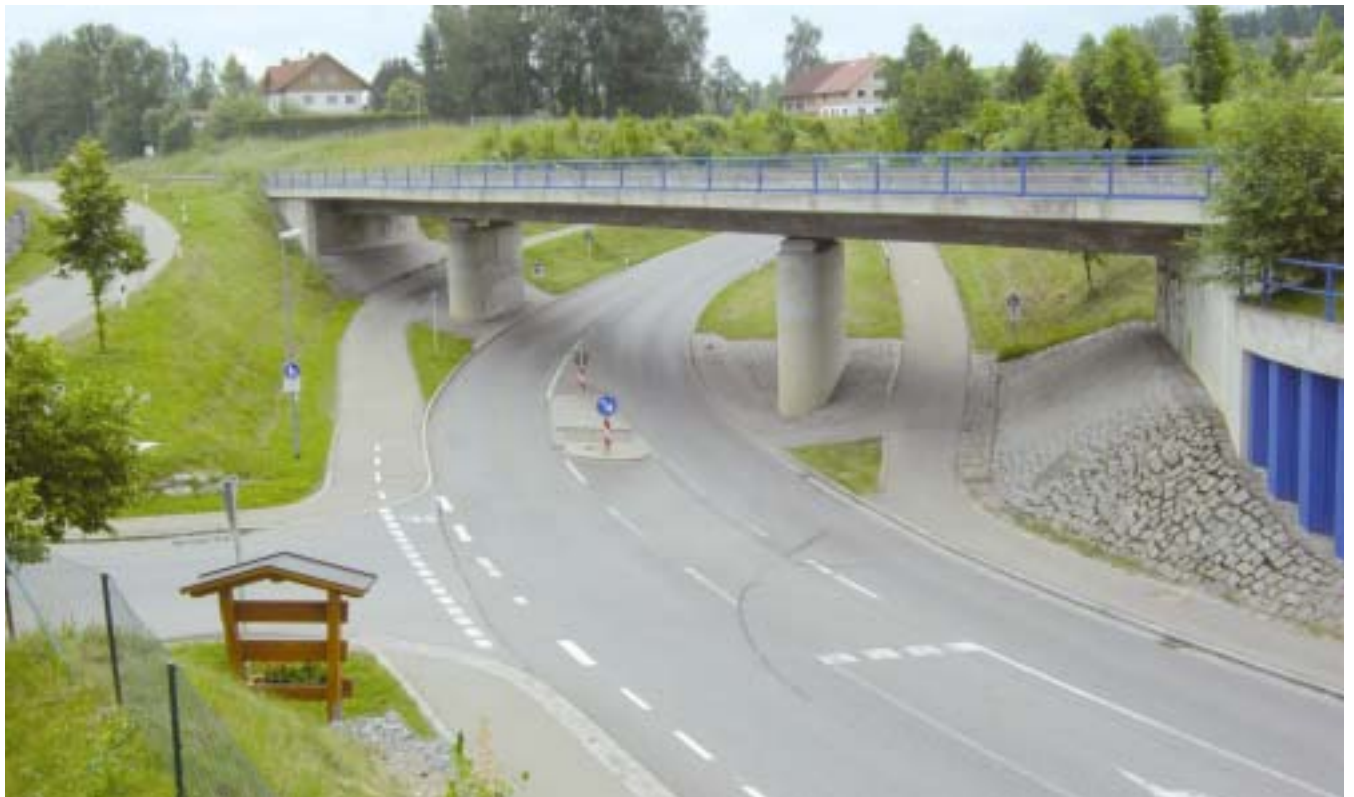
Die B32-Unterführung am Ortsende von Heimenkirch in Fahrtrichtung Oberstaufen. Wer sich das Bauwerk vor Ort ansieht, wird feststellen, dass man sich mit einer Bahnunterführung in dieser Art auch für Lindau eine gute zukünftige Lösung sichern kann. BZ-Foto: Markt Heimenkirch
