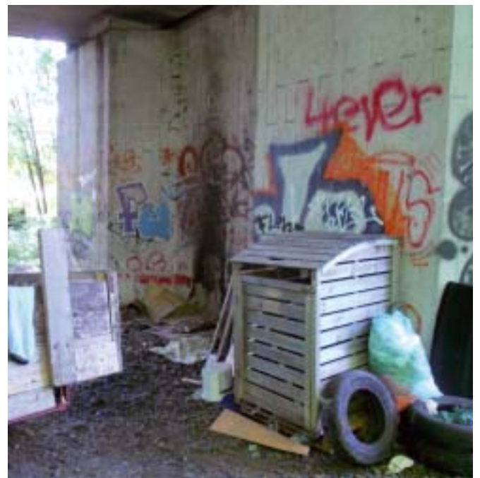
„Schöner wohnen“ unter der Brücke? So ein „Domizil“ wie hier unter der Kamelbuckelbrücke sollte in Lindau nicht noch einmal entstehen.
