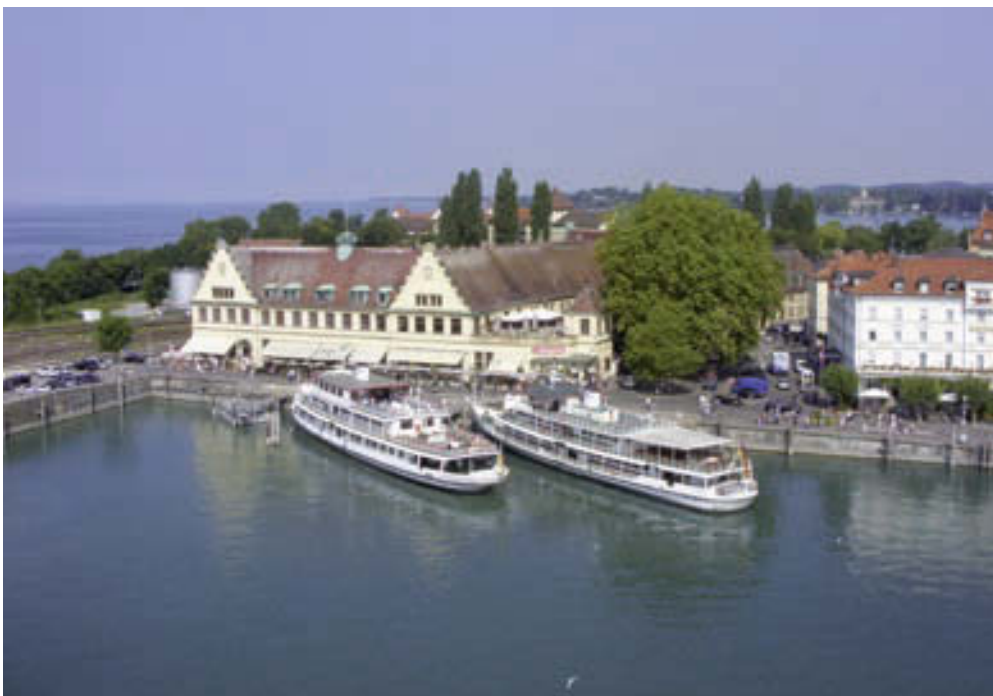
Der Inselbahnhof soll erhalten bleiben, die Gleise allerdings von acht auf sechs reduziert werden. BZ-Foto: WV
