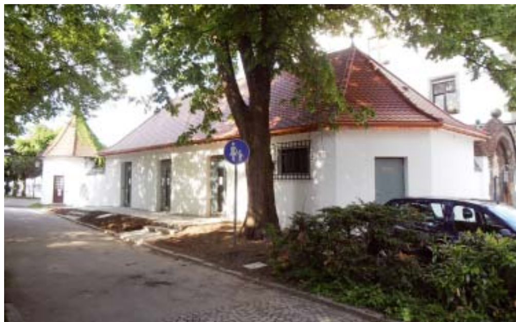
Neue Toiletten in altem Gebäude: Zwischen dem ehemaligen Hauptzollamt und dem Biergarten nahe dem Hafen wurde in den vergangenen Monaten die Anlage errichtet. BZ-Foto: WV
