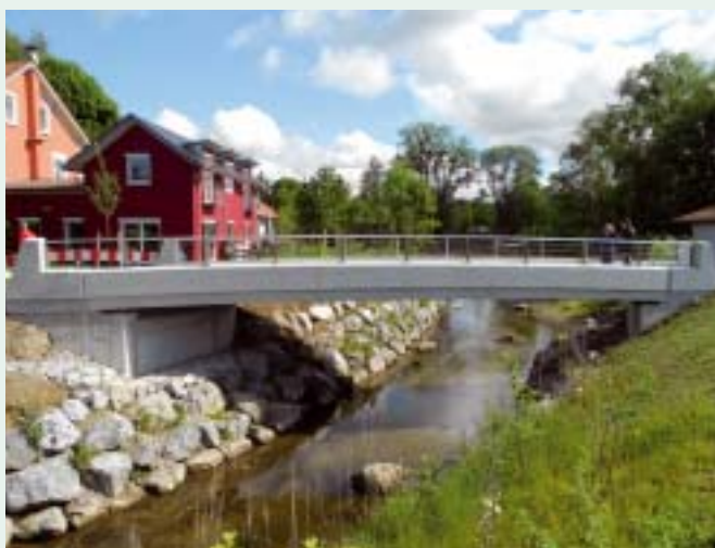
Die neue kombinierte Geh- und Radwegbrücke verbindet Reutin mit dem Schulzentrum. Sie ist rund 13 Meter lang und drei Meter breit. BZ-Fotos: WV
