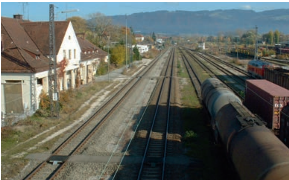
Im Zuge der Neuerstellung des Reutiner Bahnhofs sollen vier doppelt belegbare Gleise direkt am Bahnhof (im Bild links) entstehen. Dazu werden teilüberdachte Bahnsteige neu gebaut und mit einem barrierefreien Steg mit Aufzug verbunden. Südlich davon werden Abstellgleise und die Tankanlage untergebracht. Darüber hinaus entfallen laut Planung alle Gleisanlagen. Die frei werdenden Flächen können für ein neues Stadtteilquartier und Naherholungsgebiet genutzt werden.
