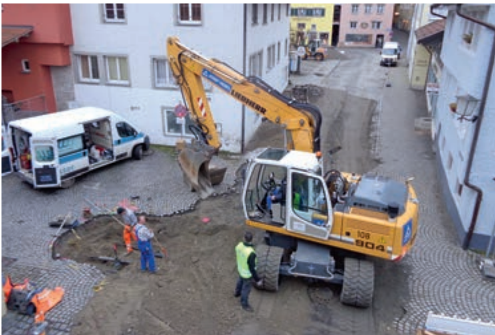
Am 20. Januar haben die Arbeiten zum Straßenausbau am Alten Schulplatz und in der Grub begonnen. Dazu gehört auch die Neuverlegung der Versorgungsleitungen der Stadtwerke und der Stadtentwässerungswerke. BZ-Foto: WV
