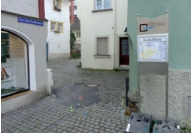
In der Hinteren Fischergasse geht es mit dem Straßenausbau und den notwendigen Sanierungsarbeiten im Kanalnetz demnächst weiter.
