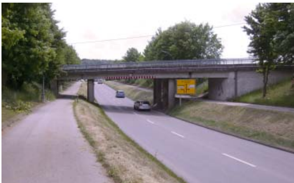
Das Bild dieser Unterführung in Marktoberdorf zeigt anschaulich, dass Unterführungen keine „Monsterbauwerke“ sein müssen. Im Lindauer Fall betrüge die lichte Weite der Unterführung von links nach rechts etwa 36 Meter, die Bahnbrücke wäre lediglich etwas breiter als 16 Meter. BZ-Foto: Michele Mongella (IWA Kempten)
