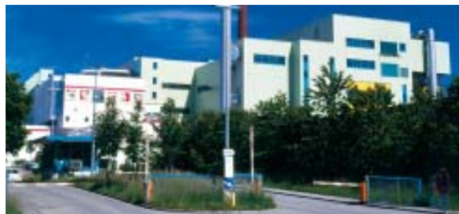
Das Müllheizkraftwerk in Kempten.
