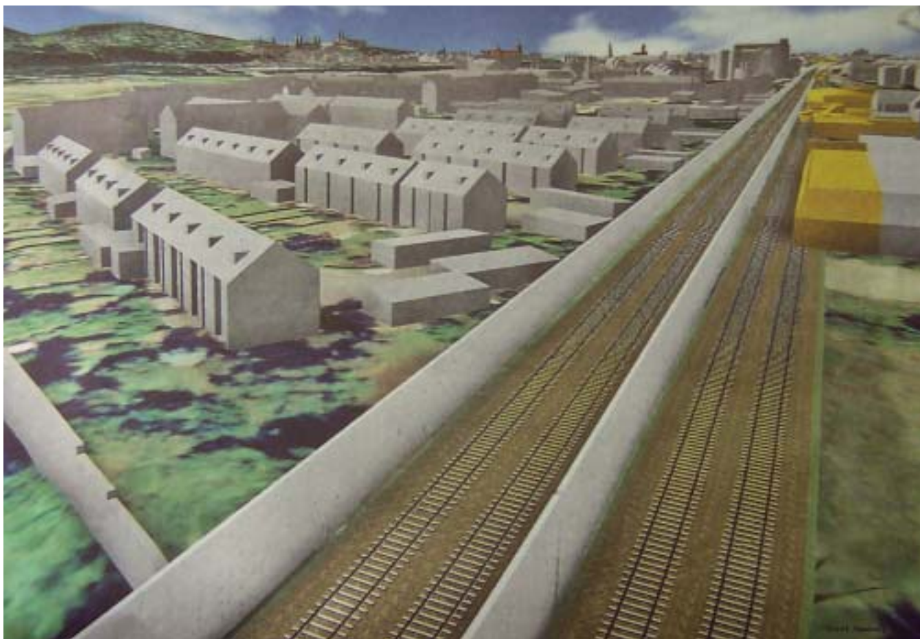
Die grafische Darstellung einer bis zu sechs Meter hohen Schallschutzwand, die in der Süddeutschen Zeitung für den Ort Bamberg veröffentlicht wurde, lässt das Ausmaß erahnen, das auch auf Lindau-Aeschach zukäme, wenn die Bahn keine Gleisabsenkung vornimmt. Quelle: Stadt Bamberg, SZ
