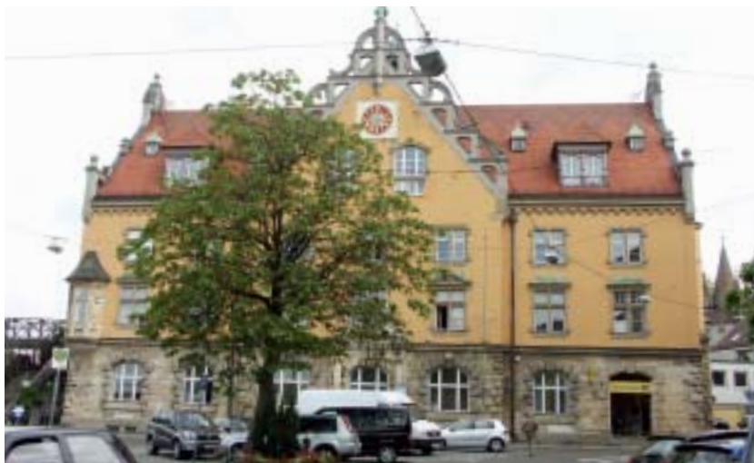
Das Postgebäude in der Maximilianstraße wurde Anfang des 19. Jahrhunderts errichtet und steht unter Denkmalschutz. Es beherbergt u.a. seit 2008 die Stadtbücherei und das Stadtarchiv. Die Stadtwerke Lindau richten im Erdgeschoss ihre neue Kunden-Insel ein.
