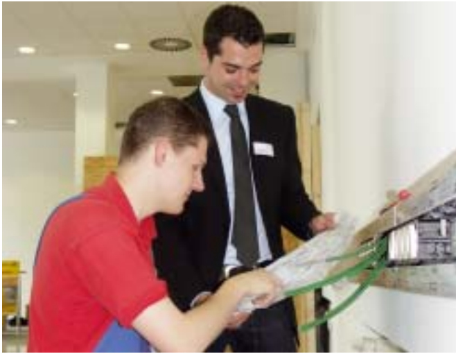
Eine der umfangreichsten Aufgaben bei der Neueinrichtung der Kunden-Insel übernehmen die Fachleute der Firma Herz, wie René Eß, mit neuen Elektroverkabelungen und Netzwerk-Installationen. BZ-Fotos (5): HG
