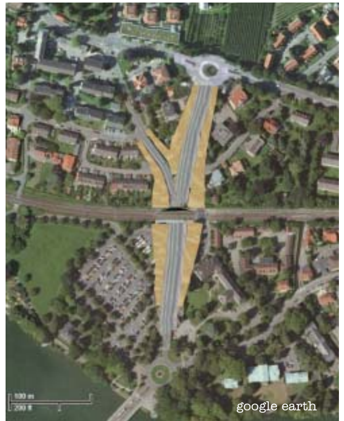
Die von der Stadt und Bahn favorisierte Unterführung funktioniert nur, wenn eine riesige Baugrube für die geplanten Bauwerke entsteht.
