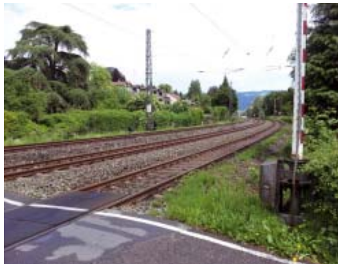
Im Bereich der Gleise in der Aeschacher Kurve sollten laut Bürgerinitiative die Gleise abgesenkt werden, so wie hier am Bahnübergang Laubeggengasse. Somit müssten erforderliche Schallschutzwände kaum höher werden als bereits bestehende hohe Hecken. BZ-Foto: STS
