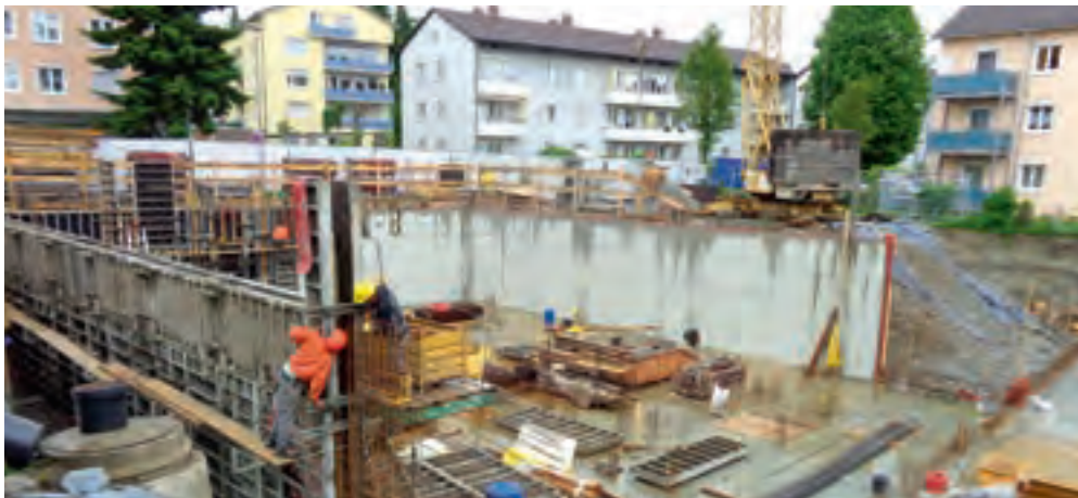
Die Strategie der Stadtplanung sieht die Entwicklung der internen Bereiche vorrangig vor der Nutzung der Außenbereichsflächen. Hauptziel ist die Schaffung von bezahlbarem Wohnraum. Hier die GWG-Baustelle an der Schulstraße.
