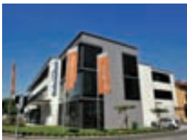
Hochbau & Tiefbau Bodenseebank, Hauptgeschäftsstelle
