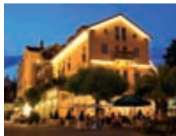
Sanierung & Hochbau Hotel Helvetia, Wellness & Tagungen
