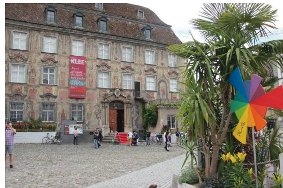
Hinter den Kulissen wird eifrig die Sanierung des Cavazzen vorbereitet.
