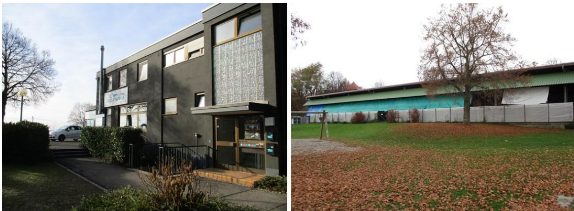
Abbildung 7: Kunsteishalle, Eingangsbereich; Kunsteishalle, Ansicht vom See
