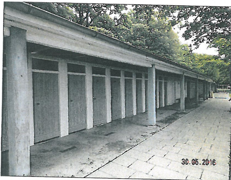
Anl. 2 Ostseite der Umkleidekabinen
